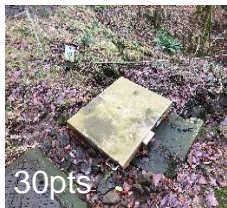
A: manhole cover
